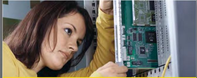
>> Telefonzentrale. Einsetzen eines Moduls.
